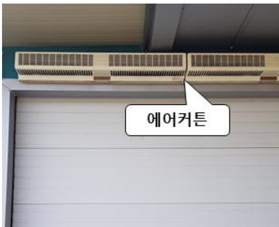
외부 출입문에 에어커튼 설치
